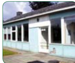
Allèges de fenêtres et revêtement de colonnes en gasal
