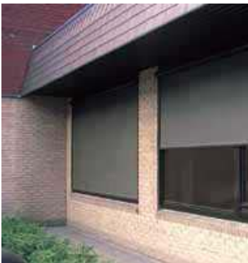
Figure 11 : stores extérieurs en toile
