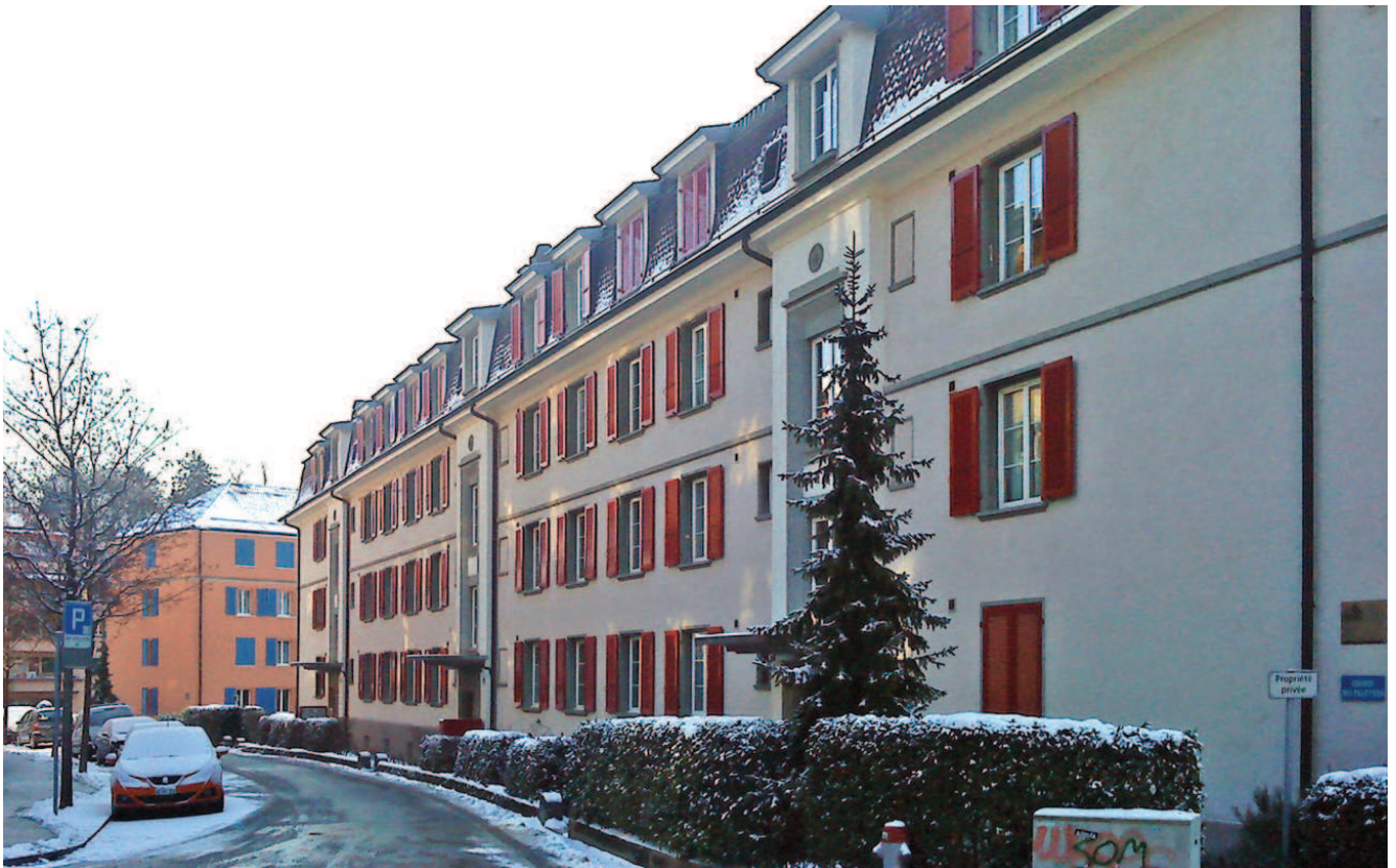
Vue de la façade nord et du chemin des Paleyres
