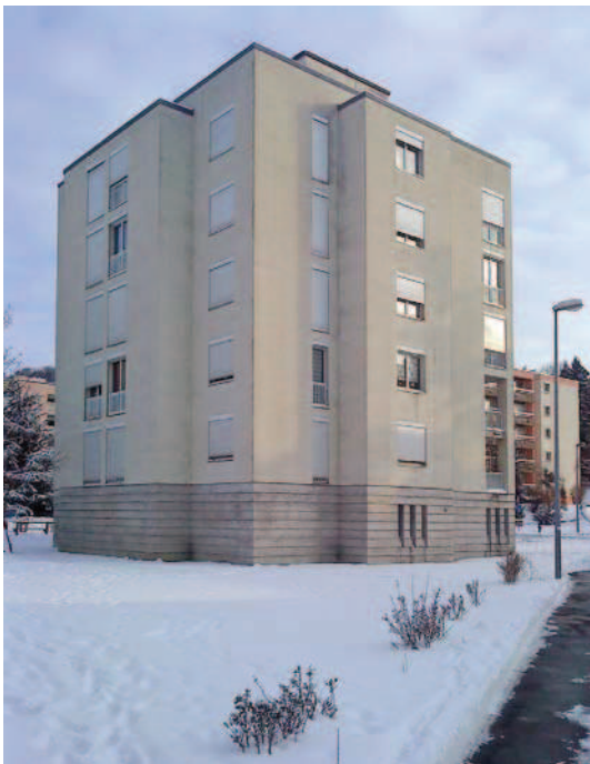
Vue d'un immeuble depuis le nord-ouest
