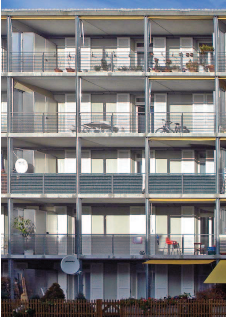
Détail d'une façade sud-ouest
