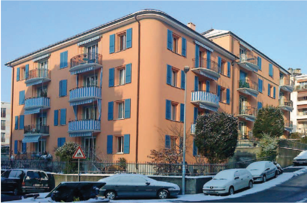
Vue depuis l'angle sud-est
