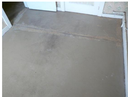
Revêtements de sol : souvent enlevés
