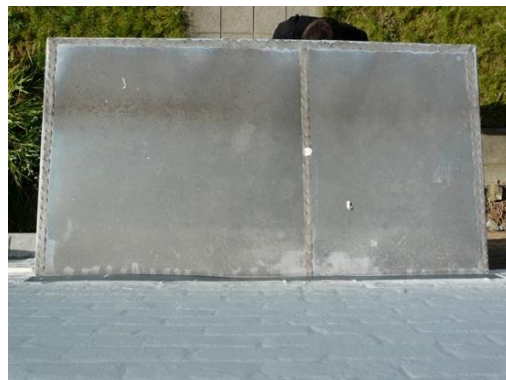
Auvent : béton couvert de zinc
