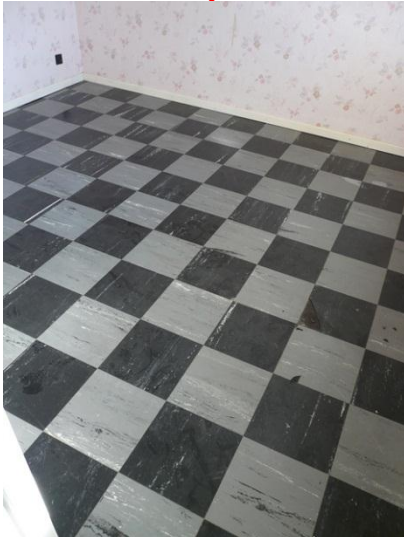
2 ème chambre : ATTENTION – couverture de sol en AMIANTE (chance de 95%)
