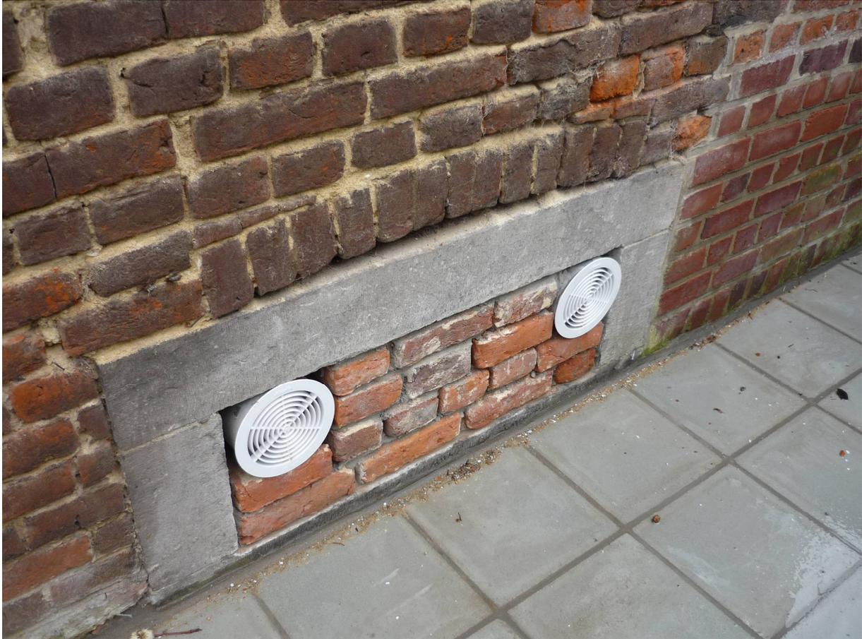
Utilisation de briques récupérées lors de la déconstruction pour combler des ouvertures dans la façade
