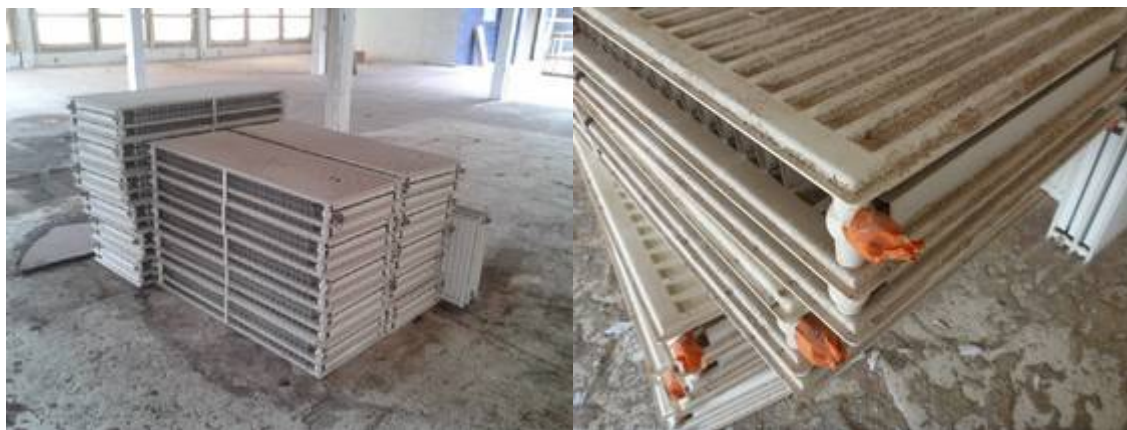
Stockage des radiateurs avec mise en place des « bouchons »
