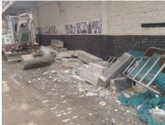
Entreposage des pierres bleues sur le chantier
