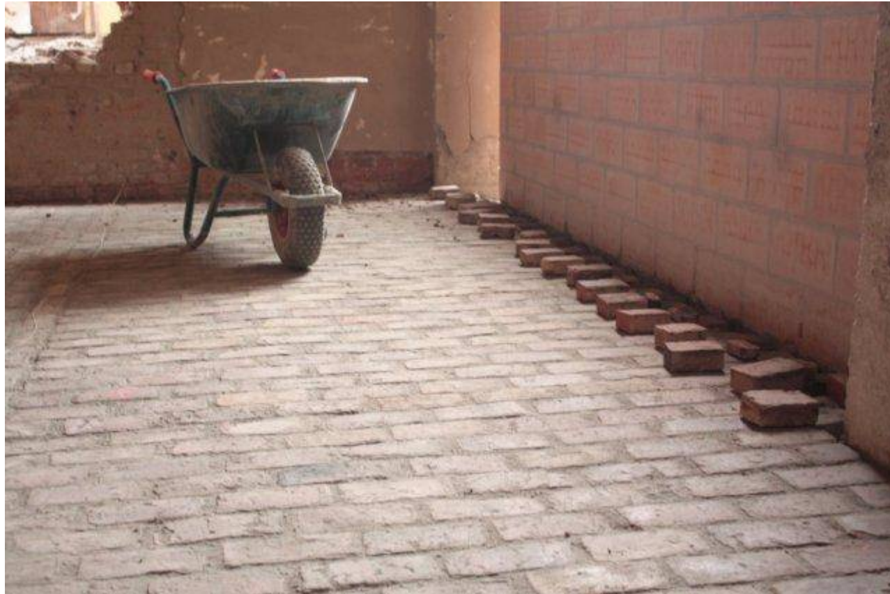
Sol réalisé à partir de briques de réemploi
