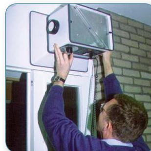
Quasiment incontournable dans le cadre de maisons passives, la mise en œuvre d'un système D nécessite une étude précise pour le passage des gaines et l'équilibrage des débits. Un tel système induit un entretien régulier.
