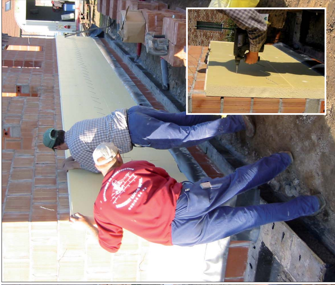
Placement d'un élément isolant (ici : verre cellulaire) sous le premier bloc pour éliminer le pont thermique
