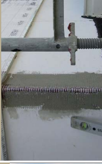
Placement des panneaux isolants destinés à être cimentés pour protéger le pied de mur
