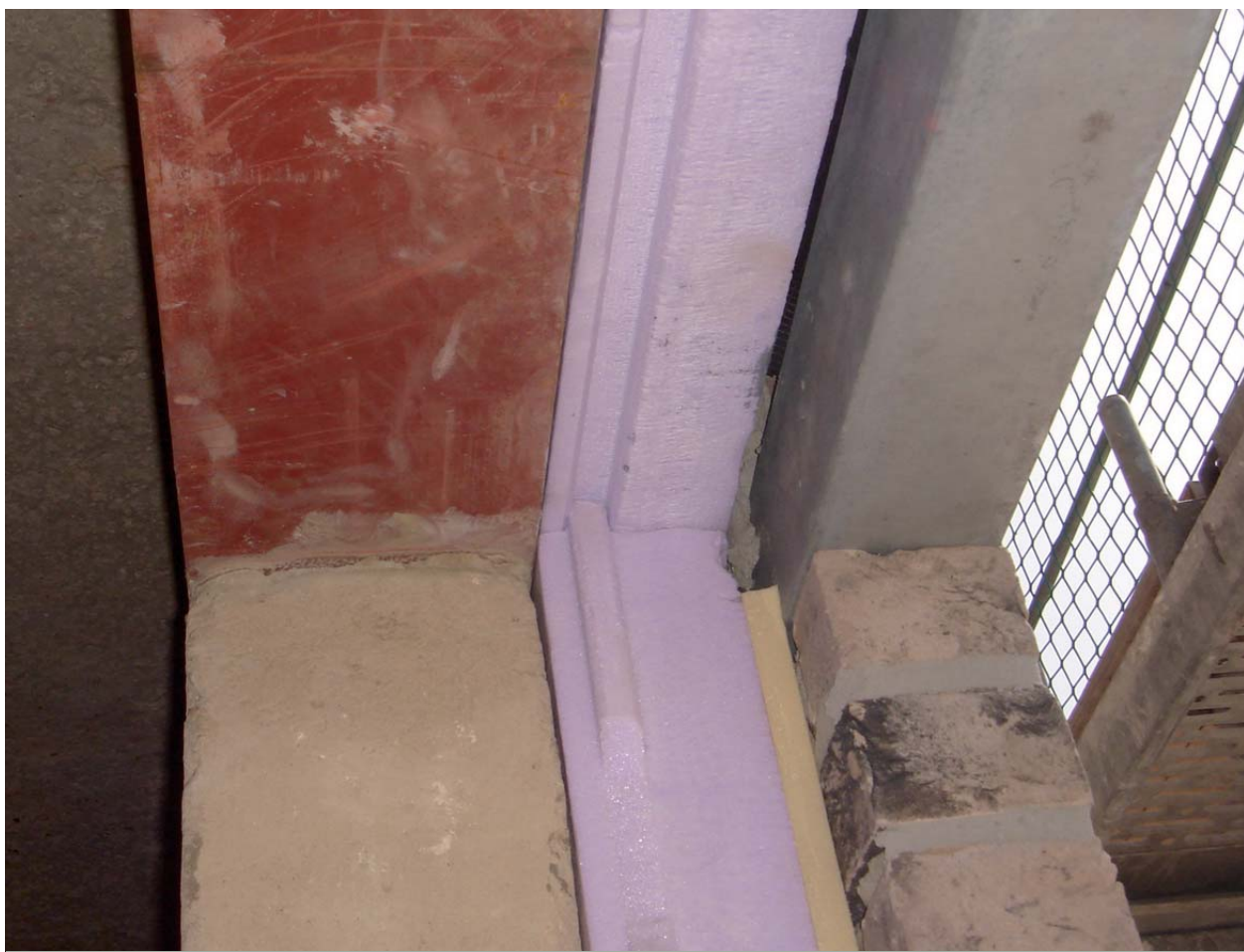
Mur creux avec 10 cm d'isolation - détail linteau
