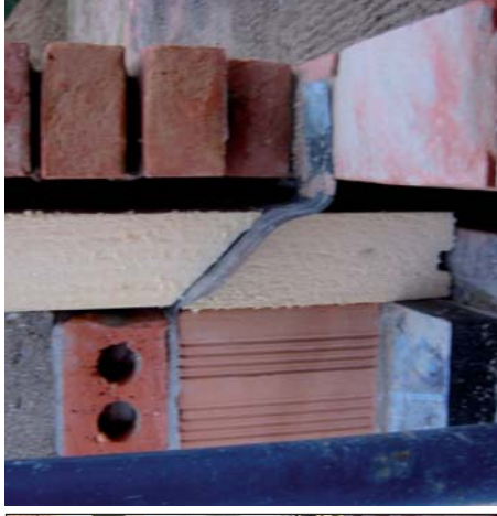
Mise en oeuvre du parement après placement soigné de l'isolation
