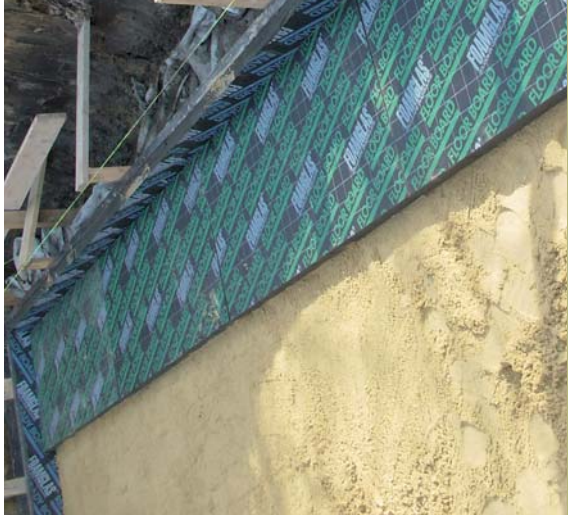
Pose des panneaux isolants
