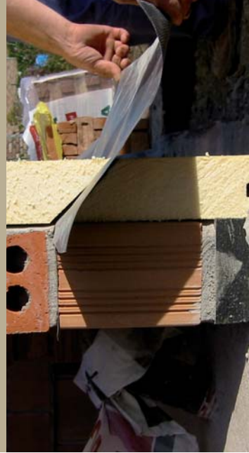
Elévation des blocs intérieurs avec pose des membranes d'étanchéité
