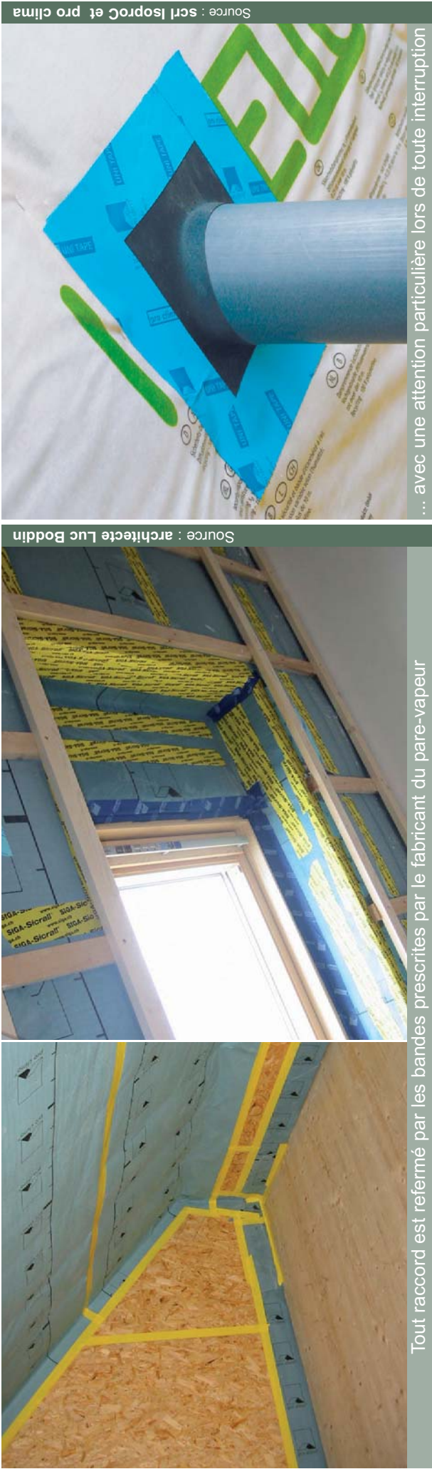
Idéalement, le pare-vapeur se pose indépendamment de l'isolation avec des bandes les plus larges possibles pour limiter le nombre de joints.
