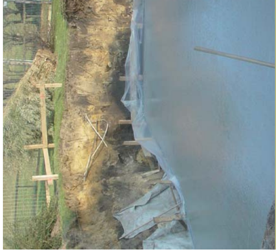
Pose des panneaux isolants
