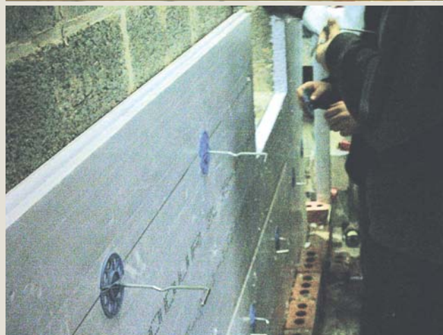
Mise en oeuvre des crochets et rosaces.
