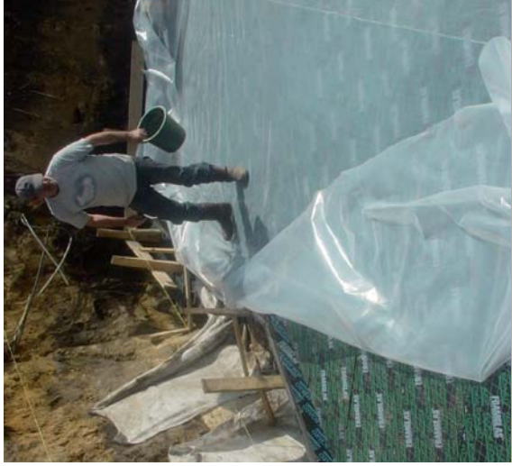
Pose d'un film polyéthylène
