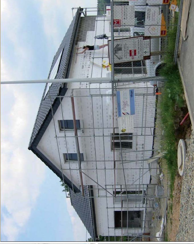
Placement de l'ensemble des panneaux isolants : contact parfait contre le mur et fermeture et alternance des joints
