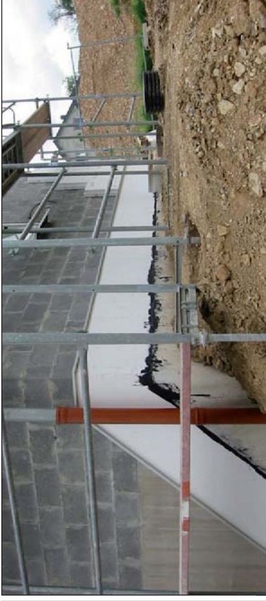
Placement des panneaux isolants destinés à être cimentés pour protéger le pied de mur
