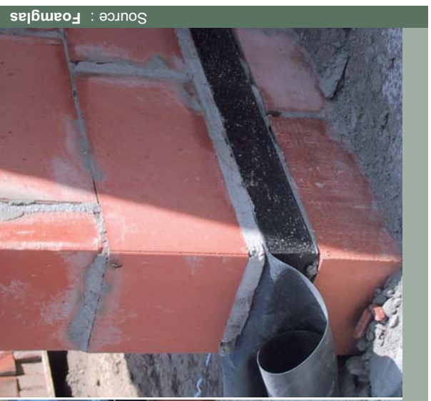
Bloc isolant en terre cuite
