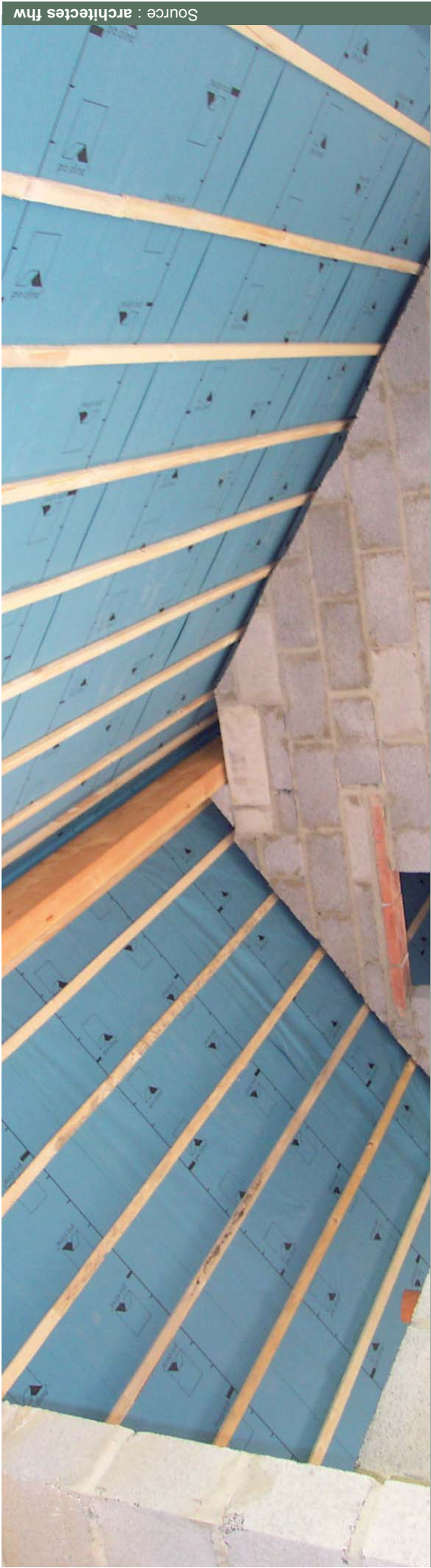
Idéalement, le pare-vapeur se pose indépendamment de l'isolation avec des bandes les plus larges possibles pour limiter le nombre de joints.
