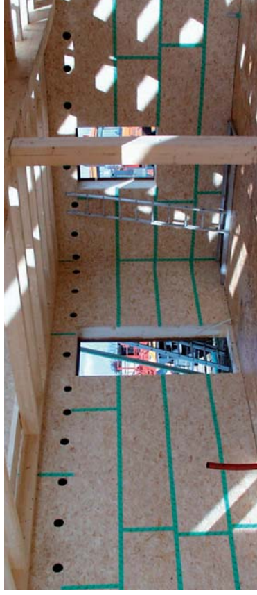
Fermeture soignée des joints
