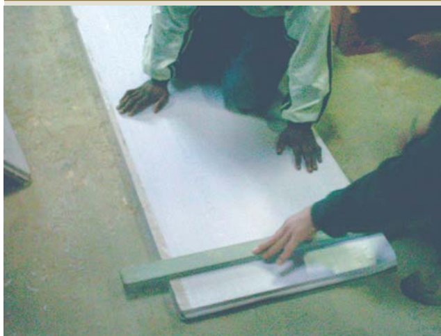
Découpe des panneaux en fonction des tenons et mortaises afin d'avoir un emboîtement parfait.
