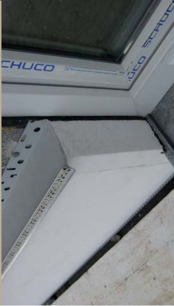
Pose des seconds profils de pied de mur
