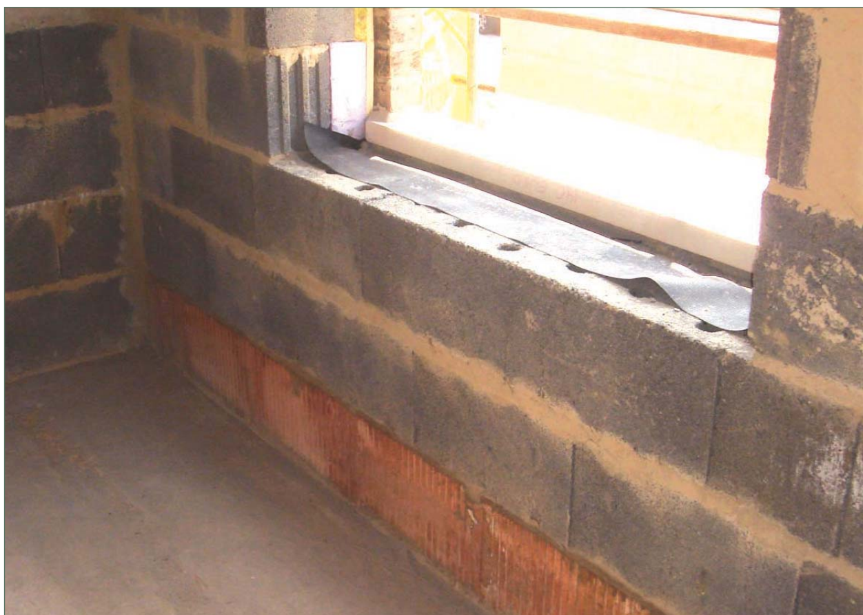
Mur creux avec 10 cm d'isolation - seuil et pied de mur
