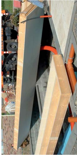
Pose du plancher sur vide sanitaire
