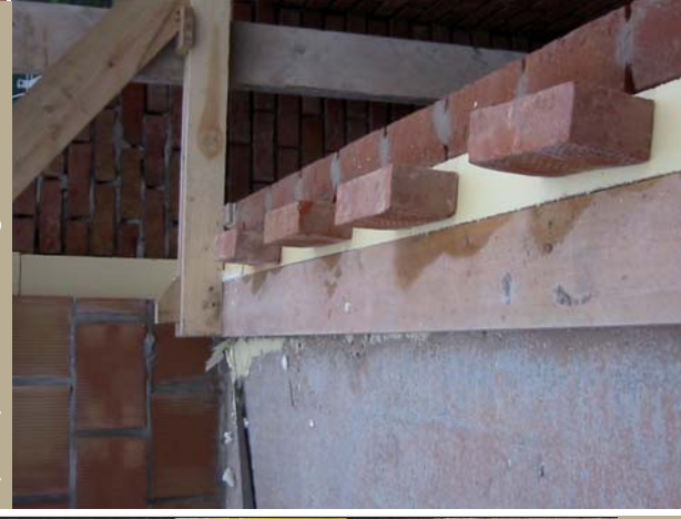
Placement des panneaux isolants contre les blocs : bon contact contre le mur + fermeture et alternance des joints. La pose des panneaux doit se faire en totale indépendance de la mise en oeuvre du parement afin de garantir la continuité de l'isolation.
