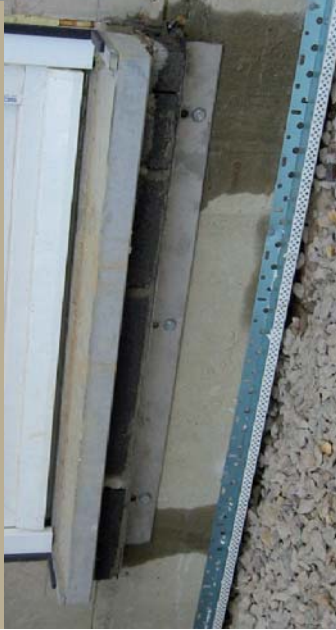
Pose des premiers profils de pied de mur
