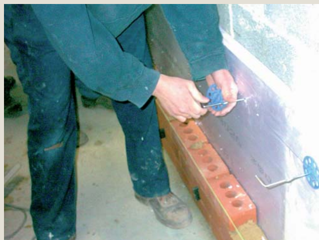
Pose du premier panneau, des crochets et des rosaces.
