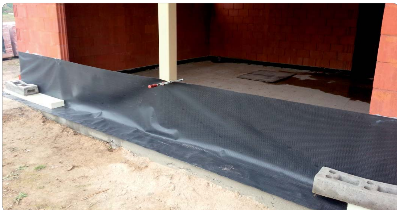
Pose de la membrane d'étanchéité
