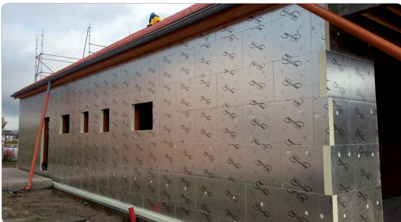
Pose soignée de la première couche d'isolation
