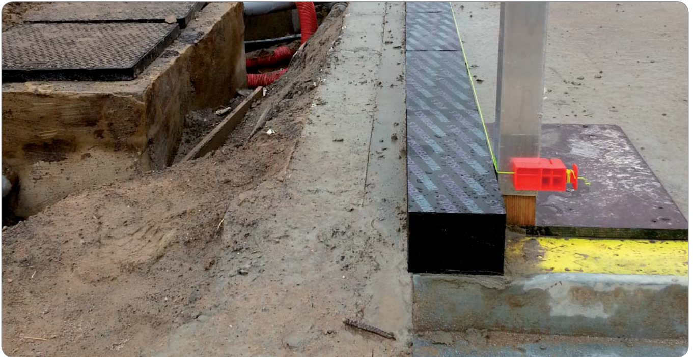
Pose du bloc isolant
