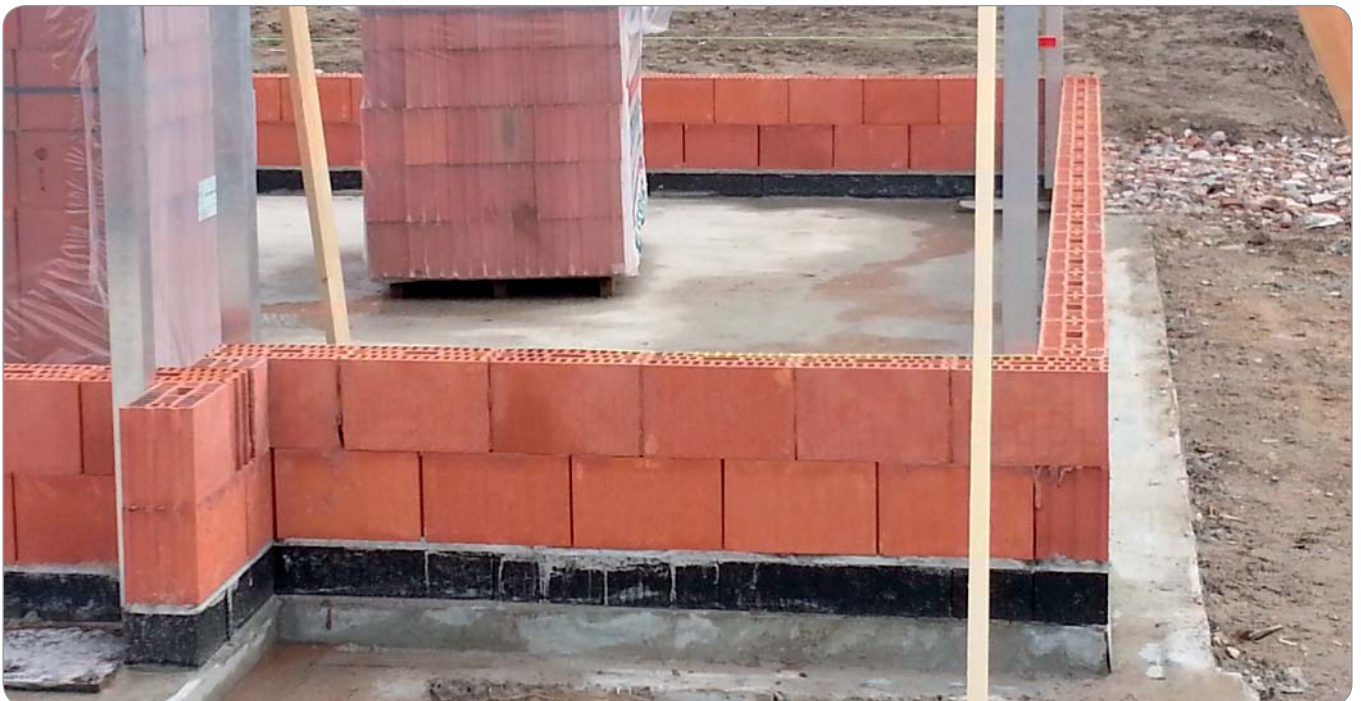
Pose des blocs porteurs
