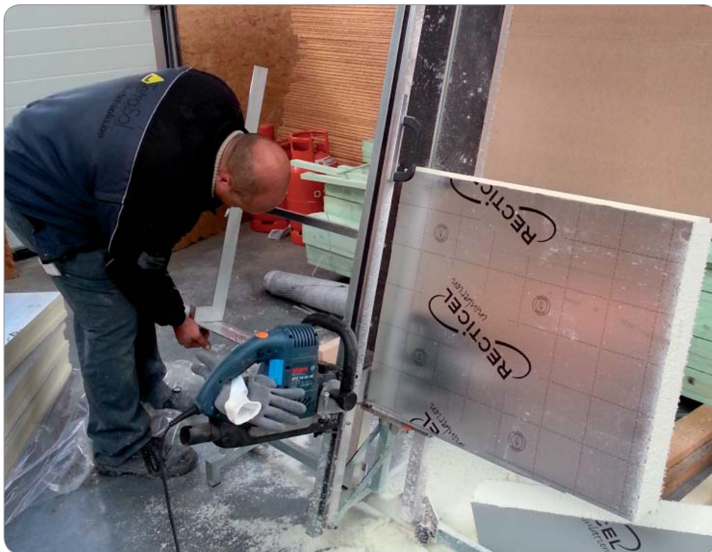
Découpe soignée des panneaux isolants
