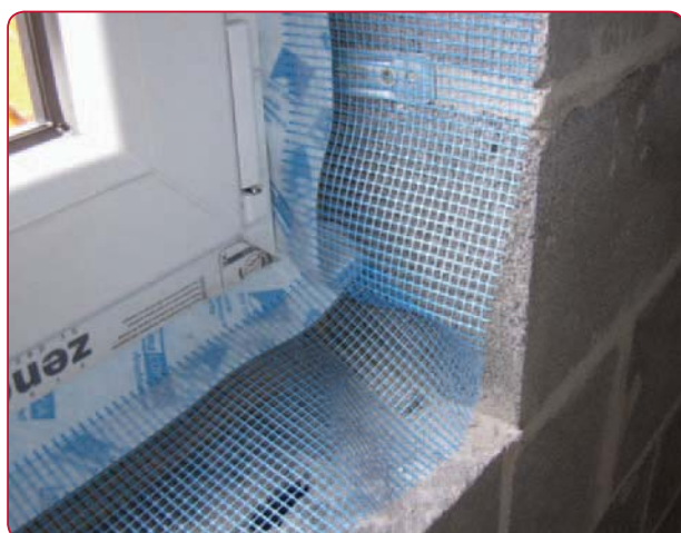
Bande de raccord entre mur et fenêtre
