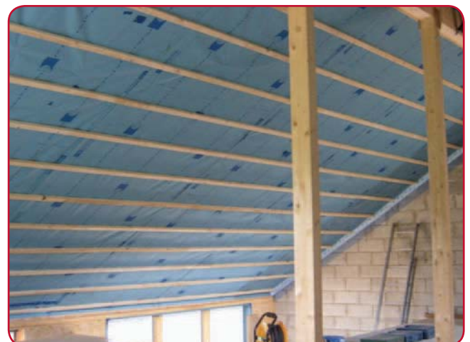
Film pare-vapeur placé dans toiture isolée
