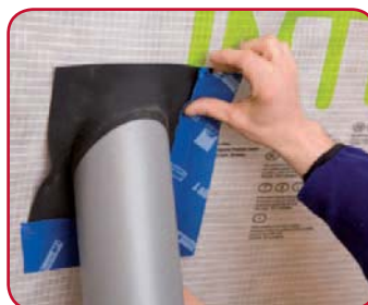
Pièce de jonction entre cheminée et toiture
