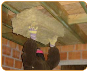
Placement de l'isolant dans un plancher
