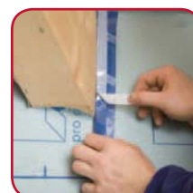
Fermeture des joints au niveau d'une panne
