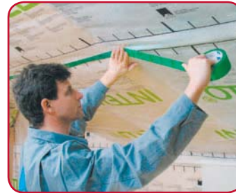
Pare-vapeur avec joints fermés par une bande adhésive
