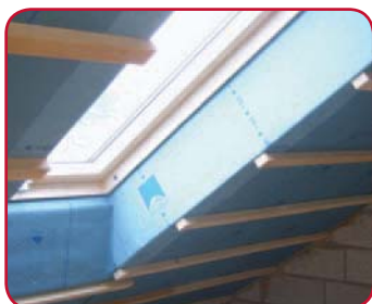
Étanchéité à l'air autour du châssis
