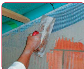
Fermeture du raccord entre mur et toiture
