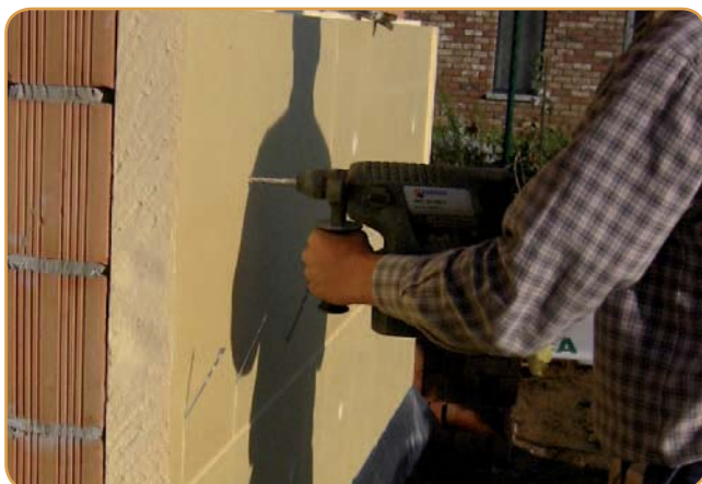
Placement de l'isolant sur un mur
