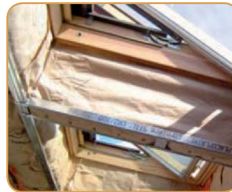
Raccord entre toiture et fenêtre de toit
