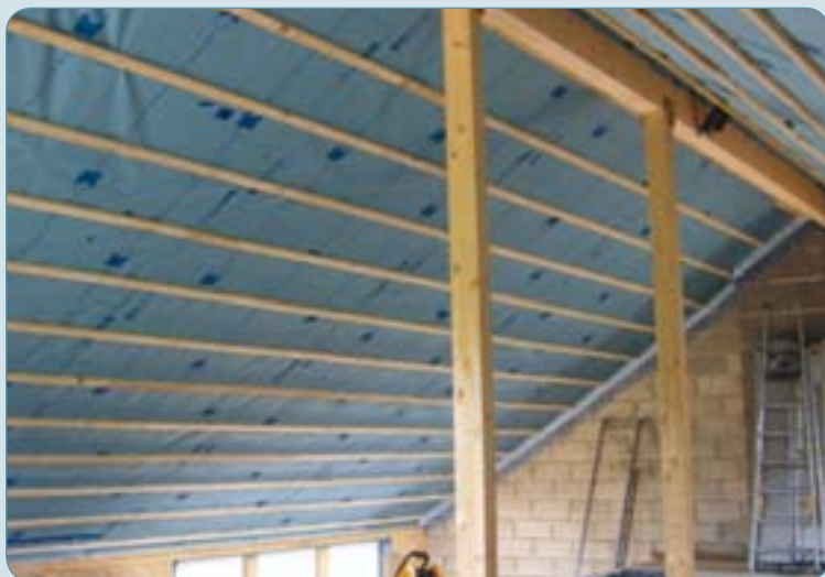
Film pare-vapeur placé dans une toiture isolée
