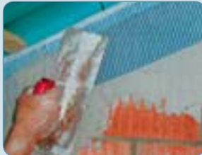
Fermeture du raccord entre mur et toiture
