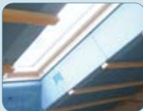
Etanchéité à l'air autour du châssis
