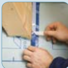
Fermeture des joints au niveau d'une panne
