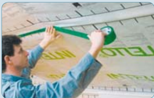
Film pare-vapeur placé dans une toiture isolée
