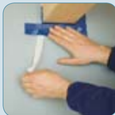
Fermeture des joints au niveau d'une panne
