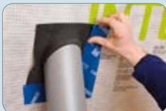
Pièce de jonction entre cheminée et toiture
