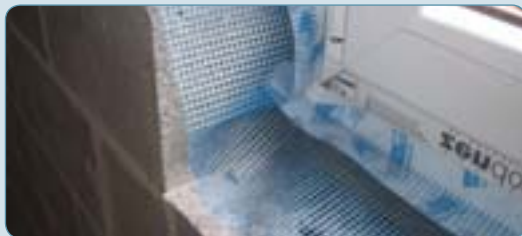
Etanchéité à l'air autour du châssis
