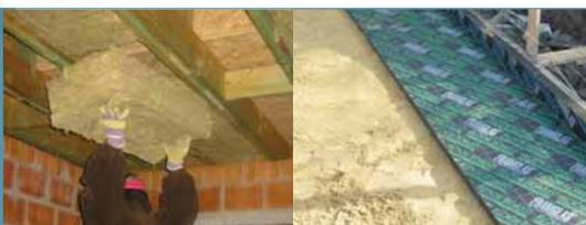
L'isolant est posé sous ou sur le support selon diverses méthodes: panneaux isolants fixés, collés ou déposés; isolant en vrac; matelas isolant dans plancher en bois; isolant insufflé...
