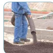
Déposer de l'argex en vrac sur le sol.
