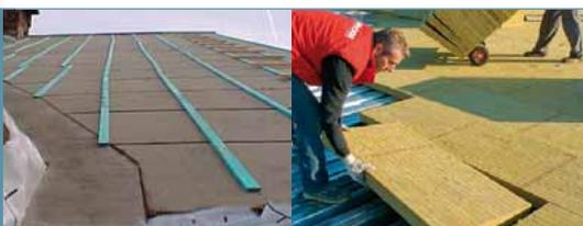
En toiture à versants, l'isolation est placée sur ou dans la charpente. Selon la situation, des panneaux ou matelas isolants sont utilisés. En toiture plate, l'isolant est posé au-dessus du support.
