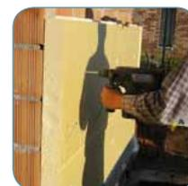
Fixer un isolant sur l'extérieur du mur porteur.
