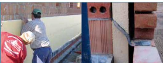
Pour les parois maçonnées, la technique la plus efficace est l'isolation par l'extérieur. L'isolant est appliqué sur le mur porteur puis recouvert d'un bardage, d'un enduit de finition ou d'un mur de parement. Pour les parois à ossature, l'isolant est placé à l'intérieur de la structure.
