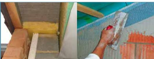
La couche isolante doit être continue. Les joints entre matériaux isolants doivent être parfaitement fermés. Les raccords entre parois isolées doivent être réalisés avec soin. Une grande attention sera portée aux nombreuses jonctions telles que mur/plancher, mur/toiture, mur/fenêtre...
