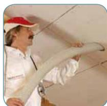
Remplir d'isolant la totalité de l'espace entre le pare-vapeur et la sous-toiture.
