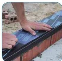
Placer un bloc isolant en verre cellulaire au pied du mur.
